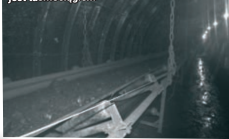
Węgiel ze ściany transportowany jest taśmociągami
