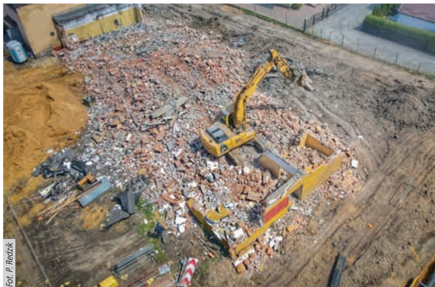
Trwa wyburzenie budynków byłego RPWiK-u. Między innymi w związku z planowaną tam inwestycją, przebudowywane jest skrzyżowanie
