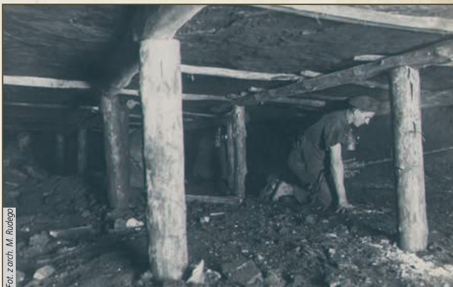
Kopalnia Waleska 1935 r. Wiercenie otworów strzałowych
