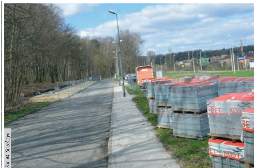
Trwają prace modernizacyjne istniejącego parkingu przy stacji PKP w Łaziskach Górnych
