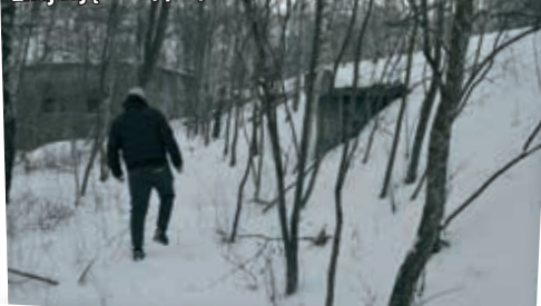
Tunel w Łaziskach Średnich oraz zabudowania, znajdujące się przy obiekcie
