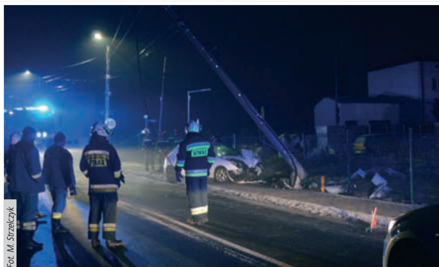
W wyniku uderzenia samochodu złamał się słup energetyczny
