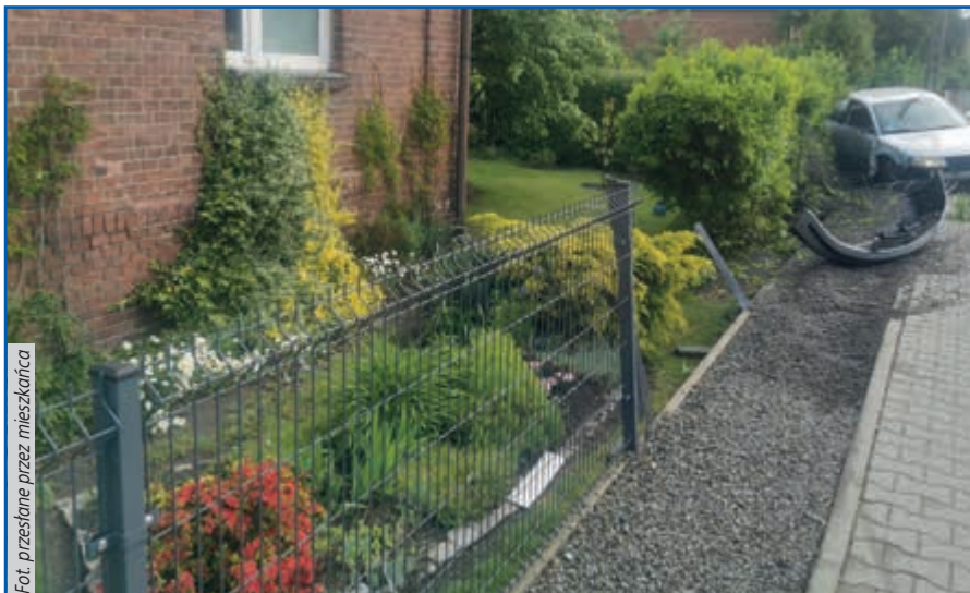
Konsekwencją licznych kolizji na ul. Brada są również uszkodzone ogrodzenia posesji
