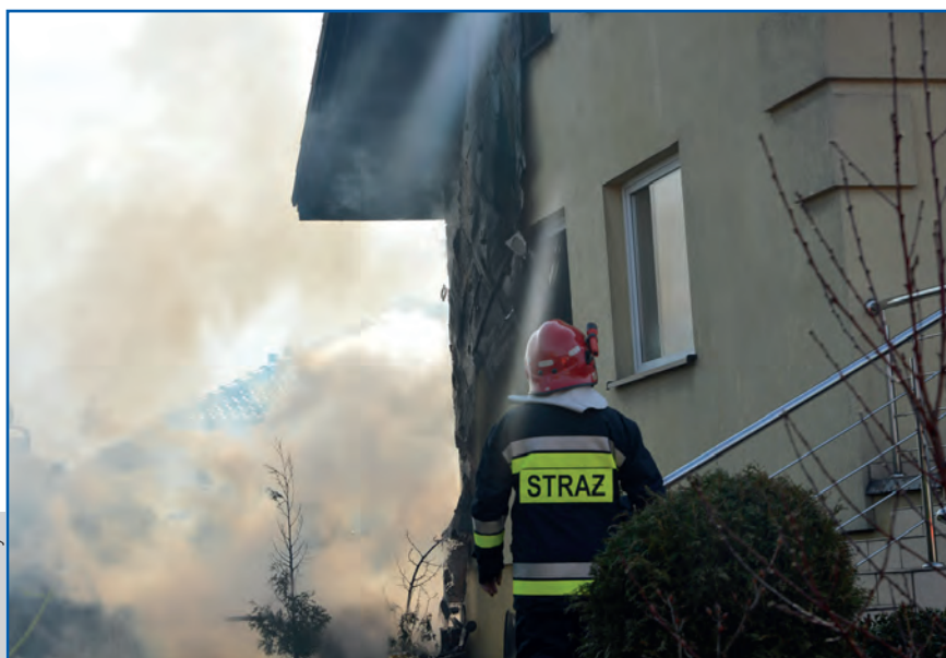
Spaleniu uległy dwie ściany budynku i częściowo dach
