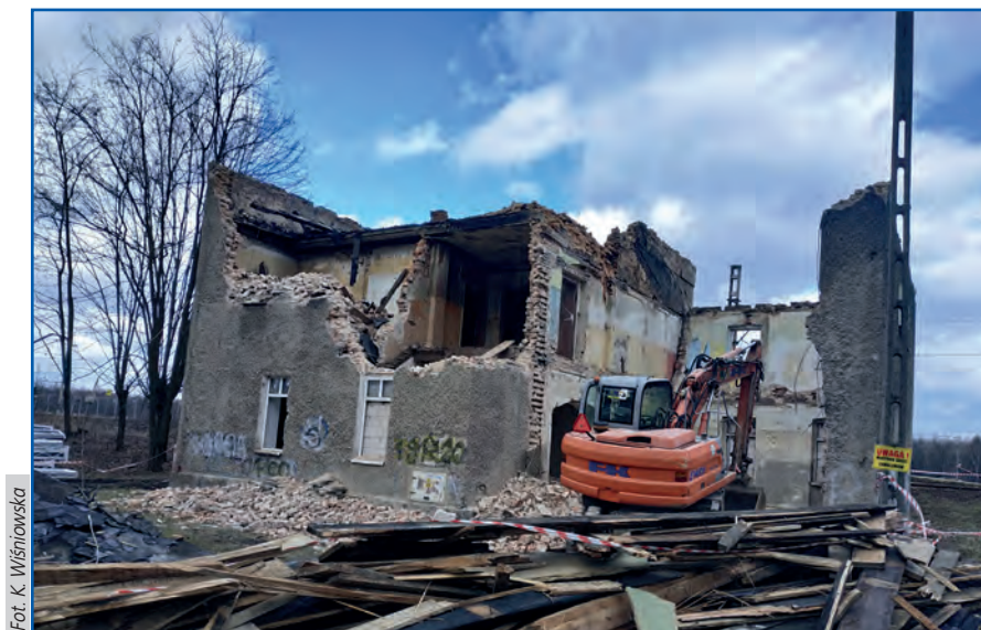
Trwa wyburzanie budynku dworca na Bradzie
