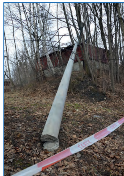
Powalony betonowy słup energetyczny przy ul. Wyrskiej
