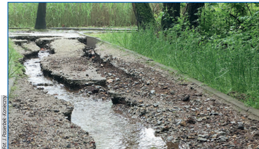
Intensywne opady deszczu zniszczyły nawierzchnię na niektórych ścieżkach za basenem Żabka
